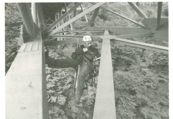
写真12 近接目視による調査・計測
