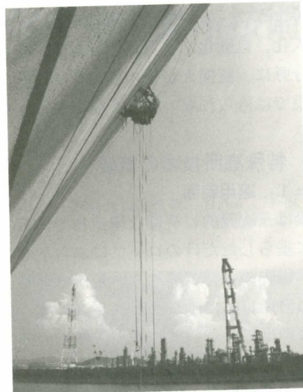
写真8 斜め方向の移動(吊橋アンカレッジ)
