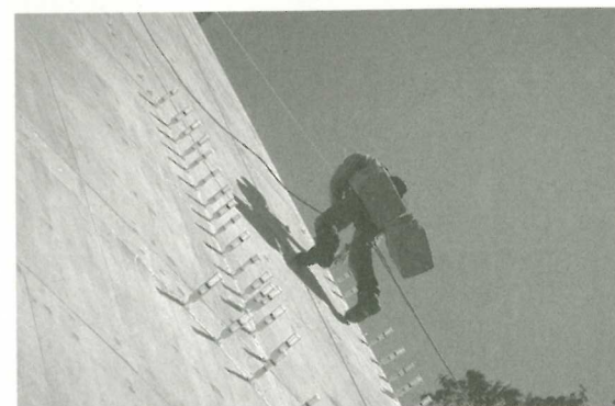
写真15 コンクリートひびわれ注入工事
