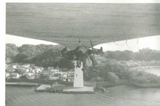
写真4 横移動の状況（コンクリート天井面）
