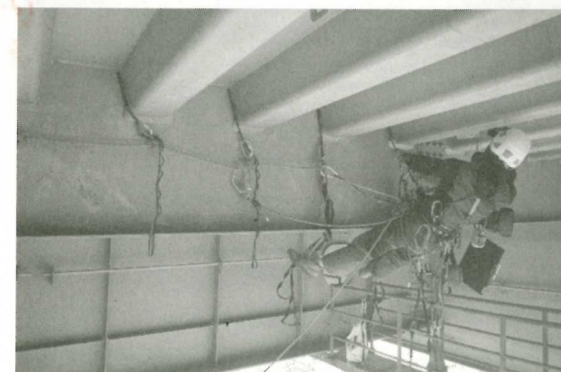
写真5 横移動の状況（鋼床版）
