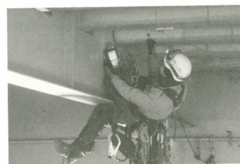
写真1 コアサンプリング作業および非破壊検査の実施状況
