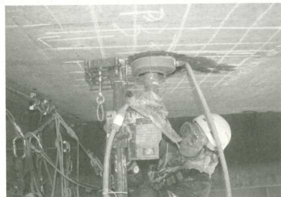
写真14 コアサンプリング(床版下面)
