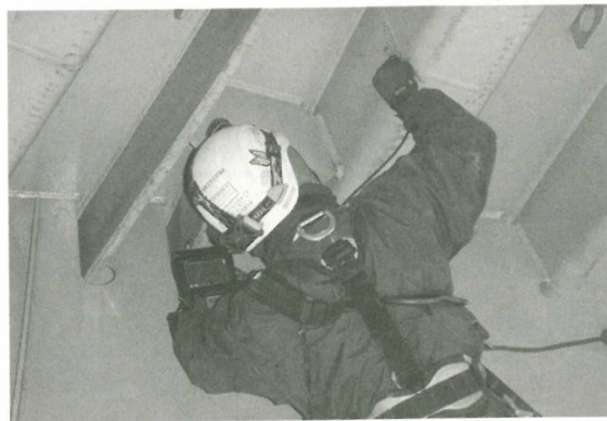
写真13 各種非破壊検査(過流探傷試験)
