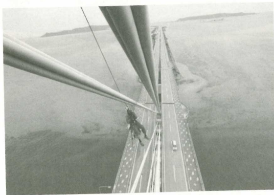
写真7 斜め方向の移動(斜張橋ケーブル)
