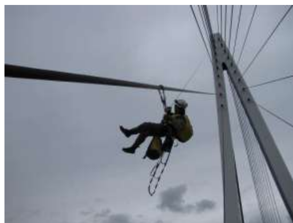
橋梁 3：PC斜張橋ケーブル点検
