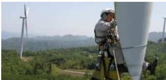
風力1・2：FRP ブレード - 近接目視及び詳細調査(ブレード表面の切削により内部の損傷確認)。
