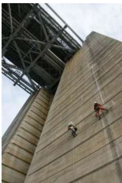
橋梁 8：コンクリートコア採取 - 海上部に位置するアンカレイジコンクリートにて
