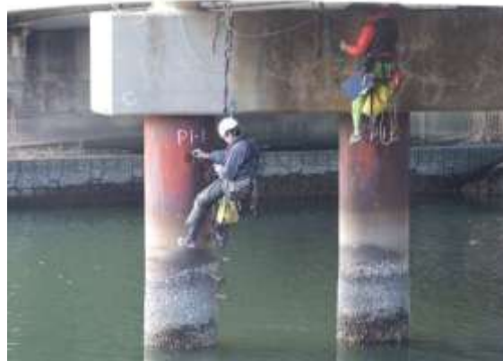
橋梁 10：超音波板厚測定 - パイルベント橋脚にて
