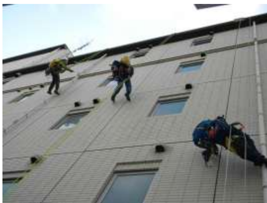
建築物1・2：ビル外壁打診・劣化調査
