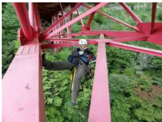
橋梁 1：上路トラス橋点検 - 峡谷に架かるため高所作業車の適用は不可能、幅員も狭く橋梁点検車の適用が不可能
