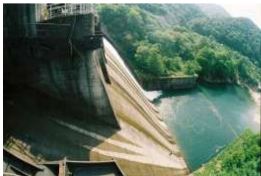
水力1：重力式ダム堤体越流部 - コンクリート変状調査
