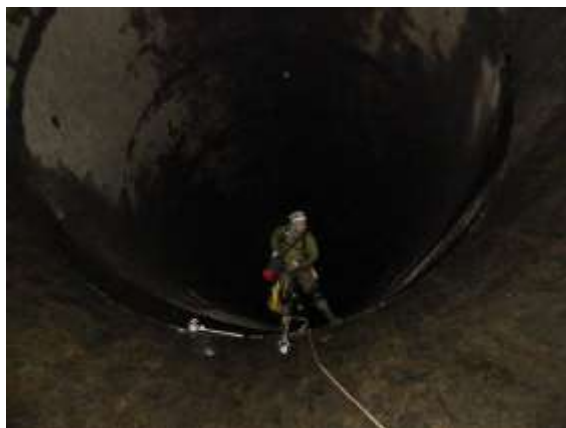
水力6：水圧鉄管路 - 内部変状調査及び超音波による板厚測定
