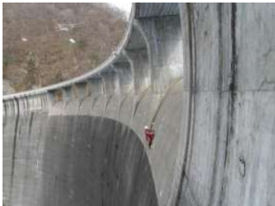
水力2：アーチ式ダム堤体越流部 - コンクリート変状調査
