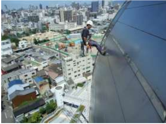
建築物 3・4：多目的イベント施設外壁劣化調査
