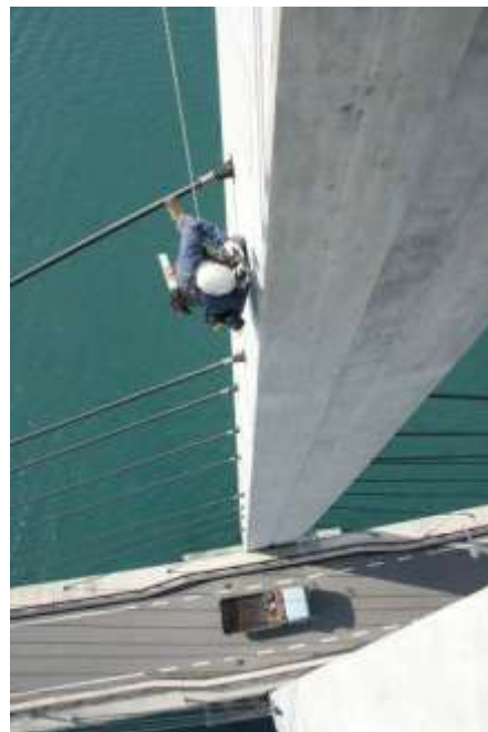
橋梁 2：PC斜張橋主塔及びケーブル定着部 - 離島と本土を結ぶ唯一の生活道路。1車線のためいずれの重機も使用は困難
