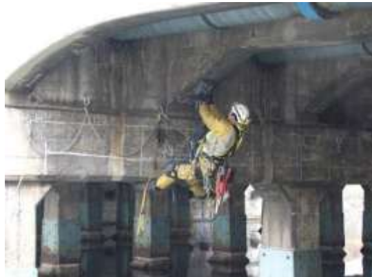
橋梁 9：RC レーダによる配筋探査 - 河川部に位置する橋脚
