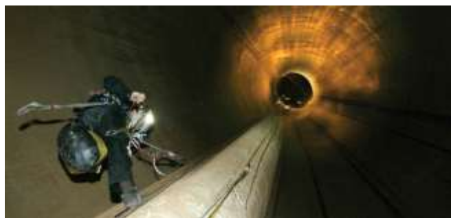
水力4：水力発電所調圧水槽 - コンクリート変状調査(直径11m 高さ140m - 現地調査期間2日間)
