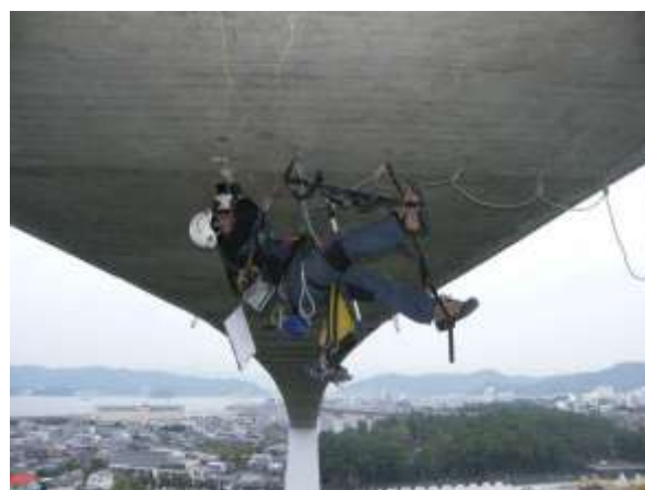
橋梁 4：PC箱桁橋コンクリート詳細調査 - 海上部 40m に位置し重機の使用不可。桁下面をアンカー打設により移動
