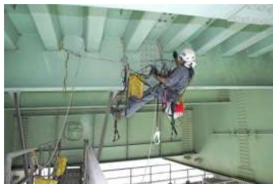
橋梁 5・6・7：鋼床版点検 - 目視のみならず、各種非破壊検査（PT・MT・ET・UT）を行うことが可能。写真は ET 実施状況
