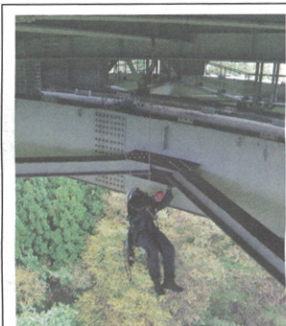
近づけなかった場所点検・応急処置
